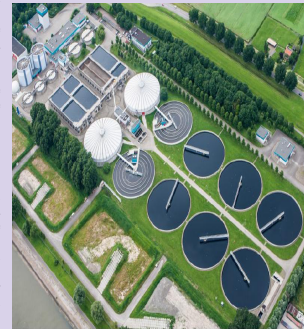
Stație de epurare a apelor uzate
